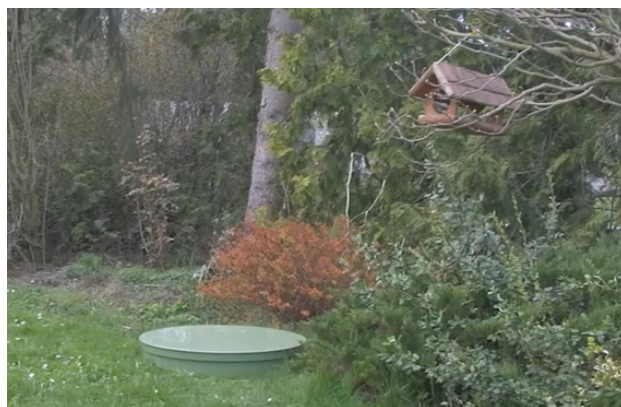
ČOV TOPAS R 5 BASIC po instalaci
